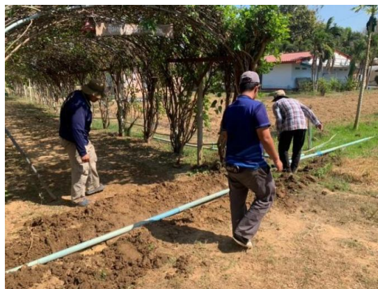
ปรับปรุงระบบน้ำภายในแปลง
