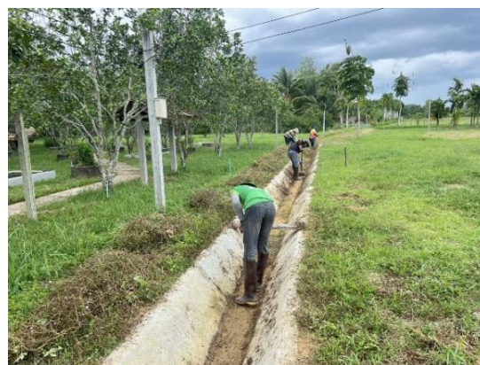
ลอกคูส่งน้ำรอบแปลงต้นแบบเพื่อเพิ่มศักยภาพ ด้านการใช้น้ำ
