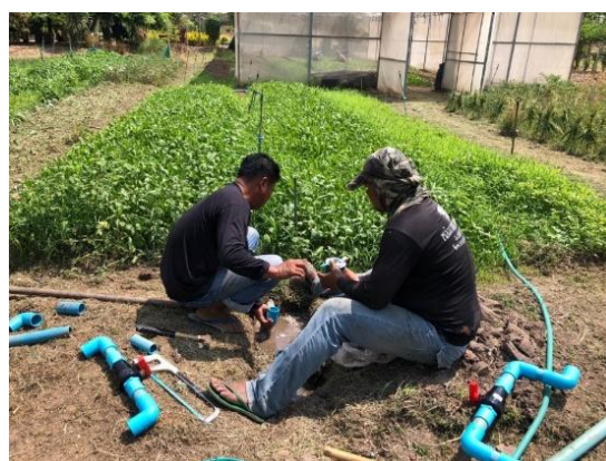
การซ่อมแซมระบบน้ำในแปลงต้นแบบฯ
